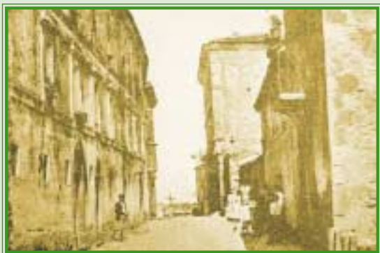
Via Cavour all'inizio del XX secolo già Via del Convento
