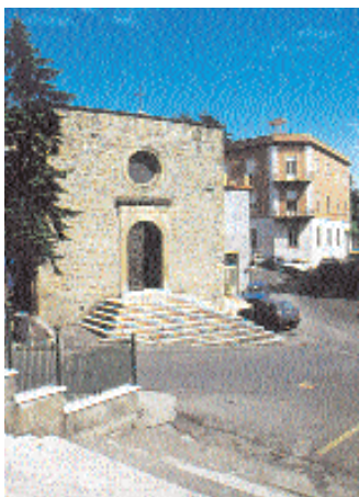
La chiesina di San Rocco, recentemente restaurata.
